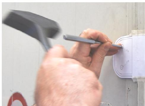
4. Realizar los pre-foros pasantes sobre la puerta con una mecha de dimension inferior (ej. 4-5mm) para así poder realizar sucesivamente desde el interior de las puertas los agujeros con una fresa a taza del diametro de 20-22mm (guiado por los pre-foros) para la insercion de los espaciadores;
