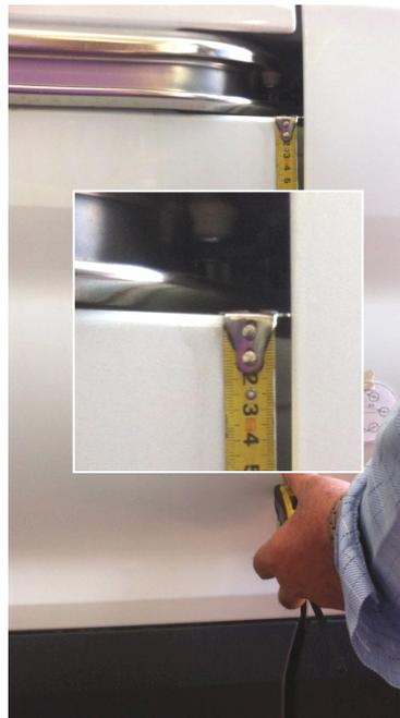
Per inserire la contro piastra del gancio/riscontro nell'interstizio del montante, aiutarsi con un lamella fissata tramite biadesivo.
