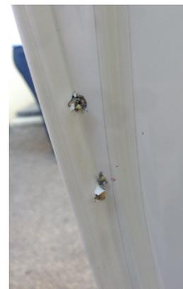
Deformar la chapa en correspondencia de los agujeros con un graver o una cuña de teflón para el cuerpo para alojar la cabeza del perno suministrado (para aplicar sin arandela).
