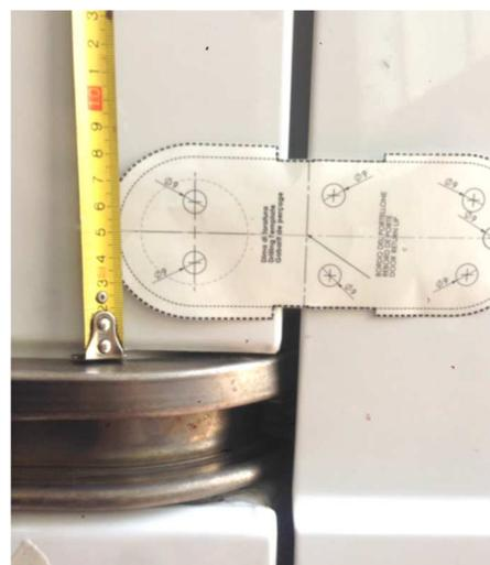
Per il fissaggio del riscontro è necessario creare un accesso attraverso il profilo scatolare del piantone. Una possibile soluzione è quella di creare due fori adiacenti e di congiungerli.
