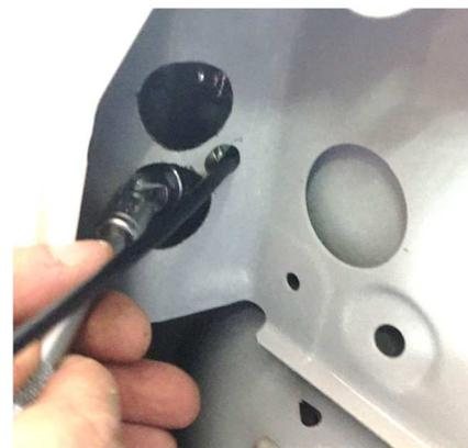
Per semplificare il fissaggio della corazza si possono utilizzare anche Plusnut (rivetto a fiore) e perno anti-effrazione da applicare dall'esterno (non in dotazione).
