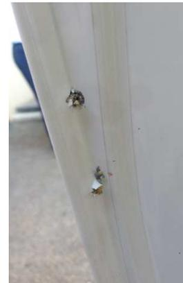
Deformare con un bulino o un cuneo in teflon da carrozzeria la lamiera in corrispondenza dei fori per poter alloggiare la testa del perno fornito in dotazione (da applicare senza rondella).
